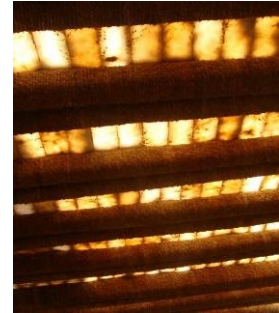
(شكل ١٩) اضاءه وتدفعه الداخل باشعه الشمس، المتخلله لكتل الرمل الابيض فى الاسقف. (١٩)
